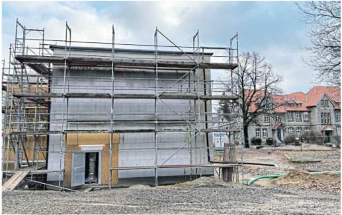
Am Neubau an der Grundschule Hillegossen wird weiter gebaut. Im Hintergrund der Altbau aus dem Jahr 1904.
